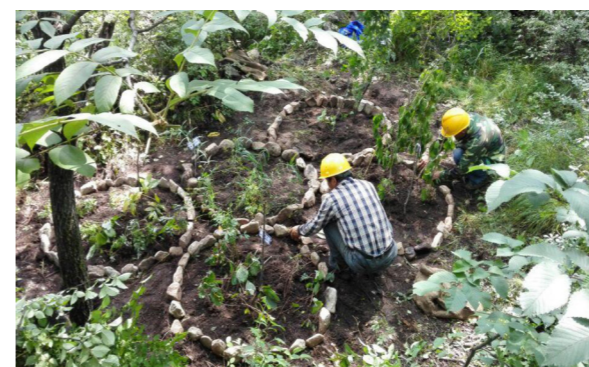
利用施工废弃材料建立移栽植物保护示范区
